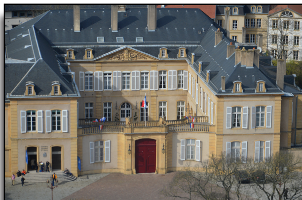
Préfecture de la Moselle
