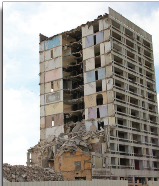
Démolition de la copropriété des Tilleuls - Uckange
